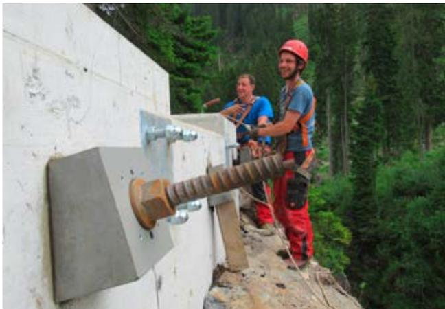
Hybridanker – Einsatzbeispiel bei der Rückverankerung eines Brückenfundaments an den Hang
