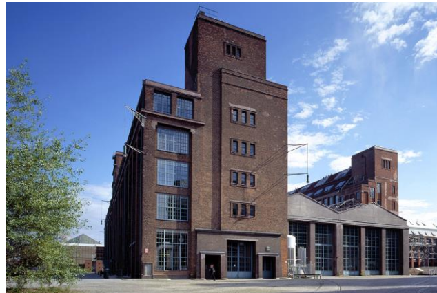
Quelle: Fraunhofer IZM / Frank Welke
